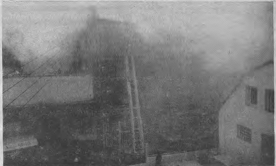
Jute, Pappe und Glaswolle entwickelten dicke Qualmwolken, die das Gebäude einhüllten.
