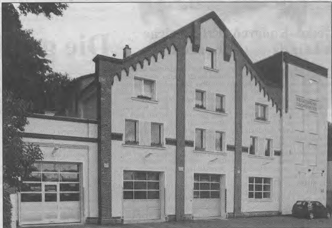
Auch bei der Feuerwehr in Cronenberg wurde zur Sanierung viel Eigenleistung erbracht. Wie sich das auf die künftige Miete niederschlägt, ist noch völlig unklar. Foto: Andreas Fischer
