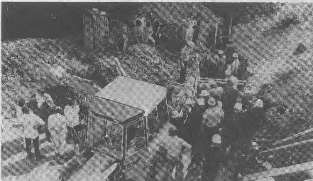
Fieberhaft wurde auf der Baustelle nach dem Arbeiter gegraben.
