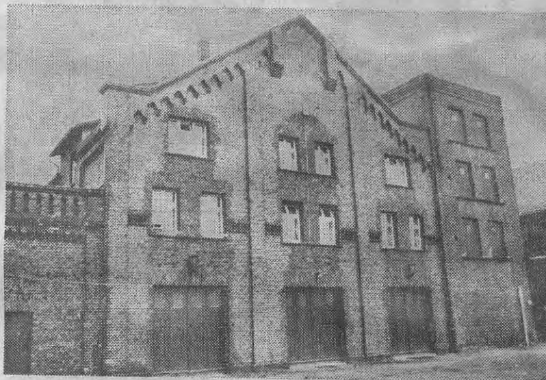
Mit diesem Feuerwehrhaus in Cronenberg ist die „Freiwillige“ recht zufrieden, doch wie lange kann sie es noch sein? NRZ-Foto: Hensel
