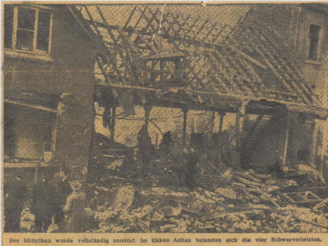
Der Mittelbau wurde vollständig zerstört. Im linken Anbau befanden sich die vier Schwerverletzten.
