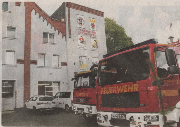
Das aktuelle Löschhaus der Feuerwehr Cronenberg in der Kemmannstraße. Seit Jahrzehnten fordert die FFC einen Neubau. Foto: (mko).
