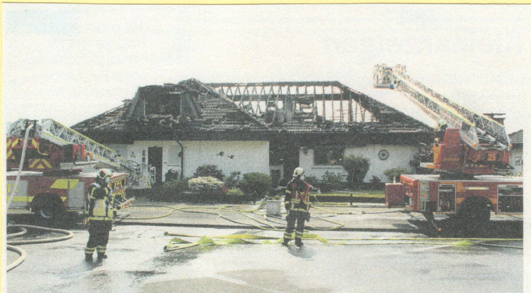
Schicksalsschlag am Oberheidt: Ein Bild der Zerstörung bot sich den Rettungskräften und den Betroffenen am vergangenen Freitag. Auch wenn glücklicher Weise niemand an Leib und Leben zu Schaden kam, sind die Folgen des Brandes verheerend.
