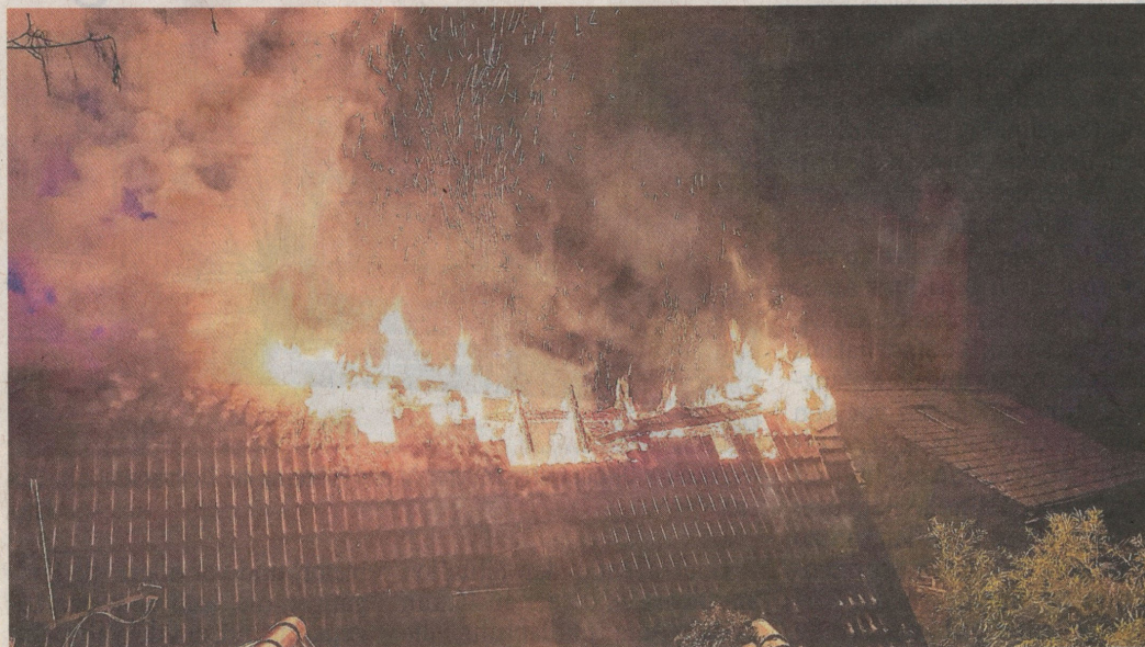
Der Dachstuhl des Leierkotten brannte lichterloh.
