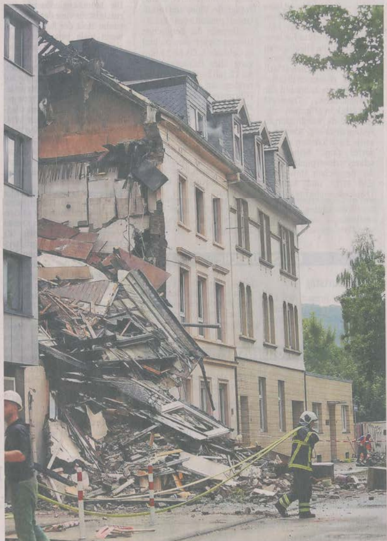
Nach dem Einsturz des Gebäudes wird es Stück für Stück abgetragen.
