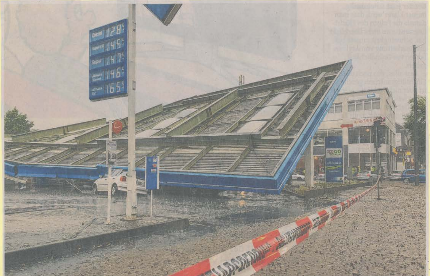
Das Dach dieser Tankstelle in Wuppertal-Barmen hielt den Wassermassen nicht stand. Der Autofahrer konnte sich noch retten.
